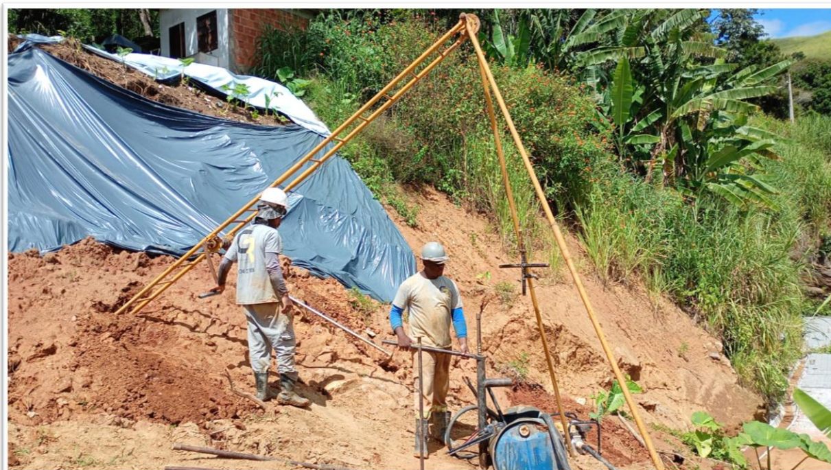
Figura 2 – Sondagem a percussão sendo realizada.
